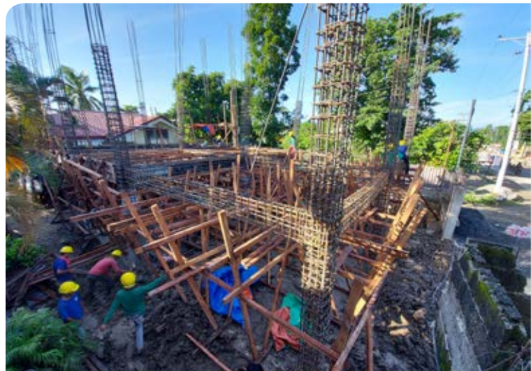
Die Baurbeiten schreiten zügig voran.
