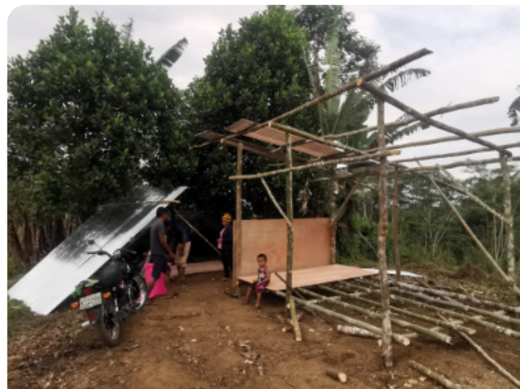
Die ersten Arbeiten haben begonnen.
